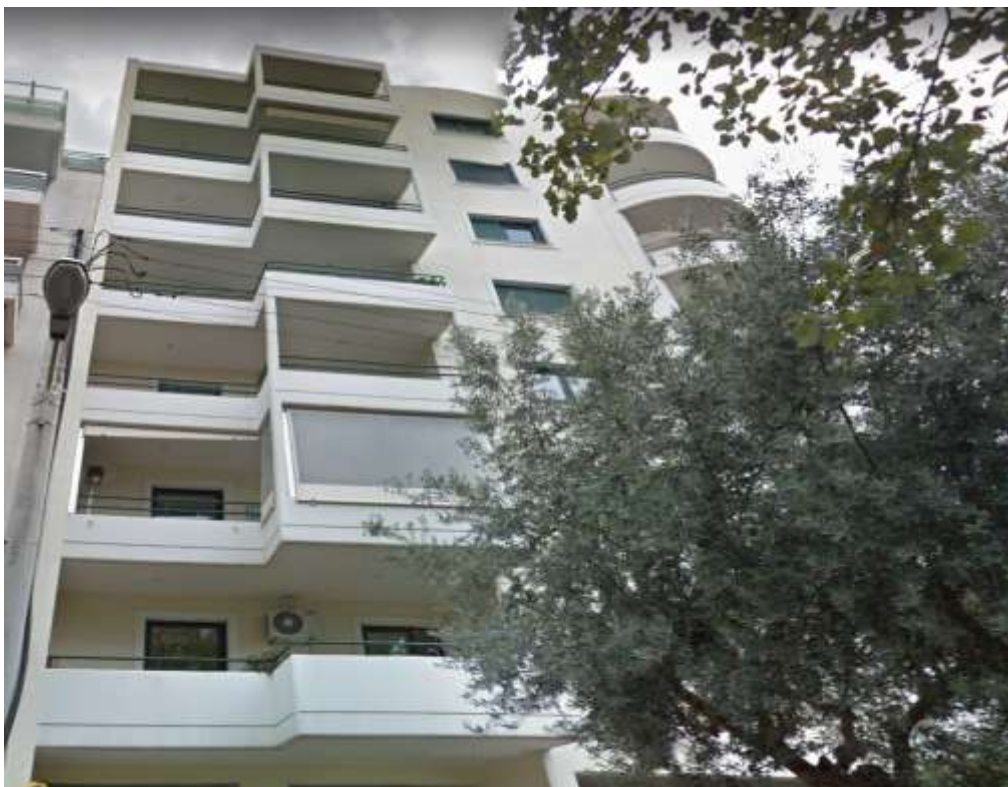
Εικόνα 1- Εξωτερική άποψη του κτιρίου
