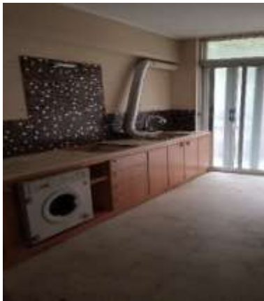
Εικόνα 2- Υφιστάμενη κατάσταση κουζίνας
