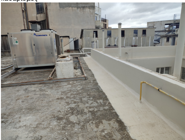
Εικ. 3 Καθαρισμός πλακών δαπέδου και απομάκρυνση μεταλλικών βάσεων
