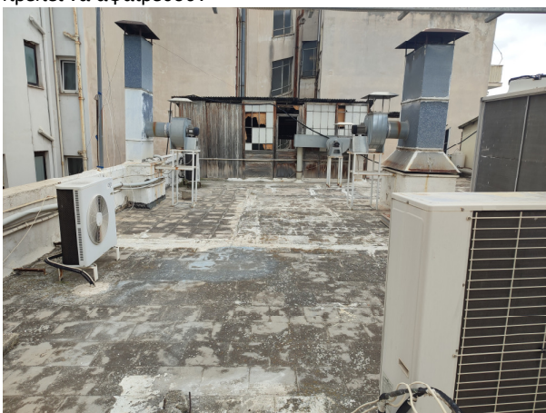
Εικ. 2 Δάπεδα δώματος προς μόνωση αφού γίνει καθαρισμός
