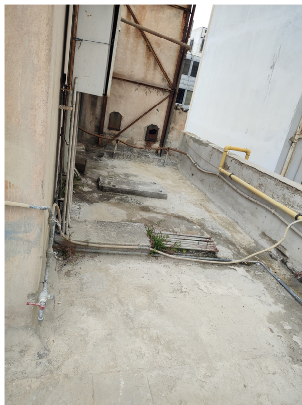
Εικ. 4 Καθαρισμός πλακών και αυτοφυών φυτών πριν την εφαρμογή της υγρομόνωσης
